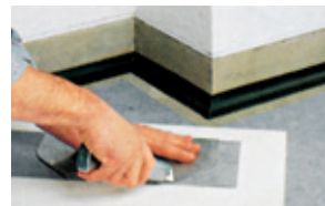
Ángulo de la junta con perfil metálico
