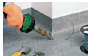
Soldadura a caldo con cordón
