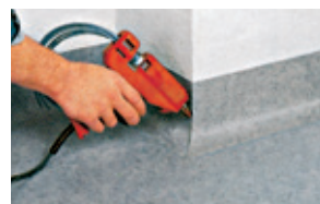
Soldadura con pistola/material de soldadura a juego.
